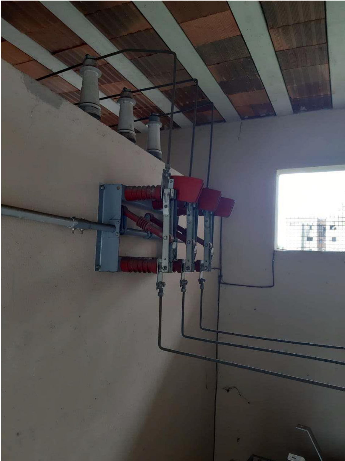
Figura 6: Chave seccionadora tripolar – abertura sem carga e sem base fusível (modelo SFT), para seccionamento entre disjuntor e transformador.
