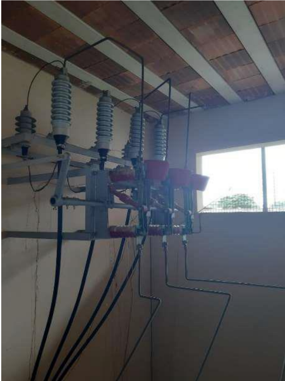
Figura 3: Chave seccionadora tripolar – abertura sem carga e sem base fusível (modelo SFT), com conjunto de para raio 15KV polimérico
