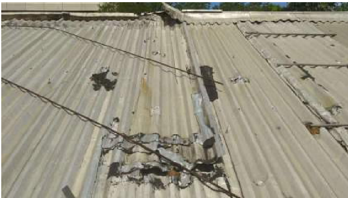
FOTO 02 – COBERTURA PAVILHÕES – CAMPUS MARACANÃ
