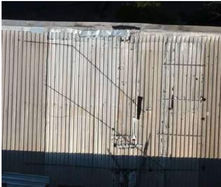
FOTO 01 – COBERTURA PAVILHÕES – CAMPUS MARACANÃ
