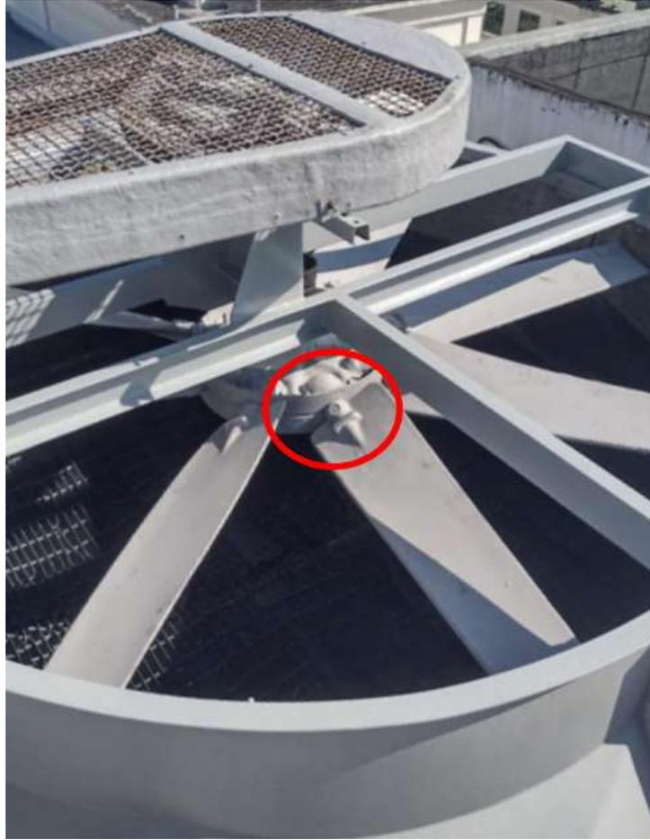
**Figura 14 - Representação real da fixação da pá da hélice no cubo – Autor (2021)**
