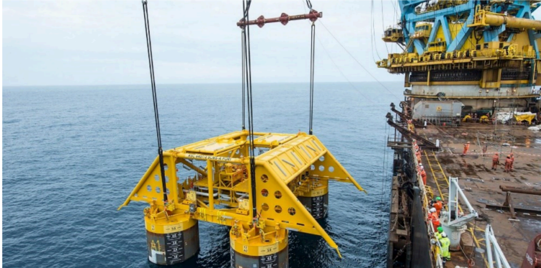
Figura 4 - Instalação de Manifold por Spreader Bar
