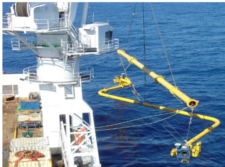
Figura 20 - Configuração de um spool rígido em Z Fonte: <www.montcalm.com.br> Acesso em 14/02/2016
